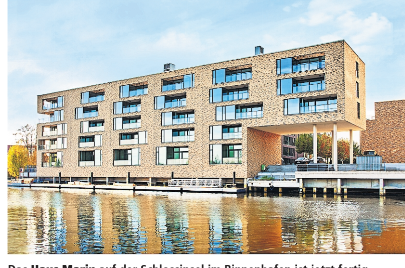
Das Haus Marin auf der Schlossinsel im Binnenhafen ist jetzt fertig.
